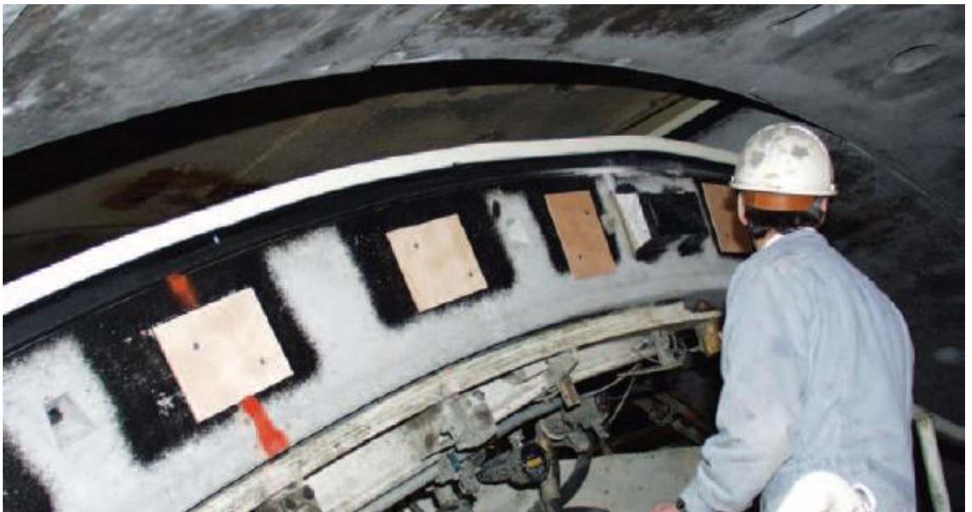
Figuur 8 Toepassing van triplex als ringvoeg materiaal
